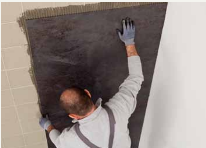
fig.38 / Укладка плитки.
