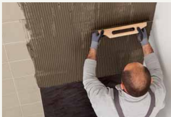
fig.35 /Нанесение клея на стену
