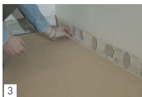
3 Posizionare i distanziali lungo il perimetro Fit the spacers around the outer edge
