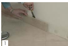
1 Eliminare il battiscopa Remove skirting
