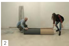
2 Stendere il tappetino Lay the underlayer
