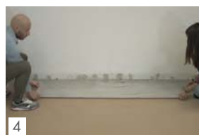
4 Posare il pavimento senza fuga Lay the floor tiles with close joints
