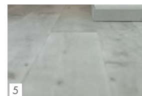
5 La superficie risulterà perfettamente planare The finished floor will be perfectly flat
